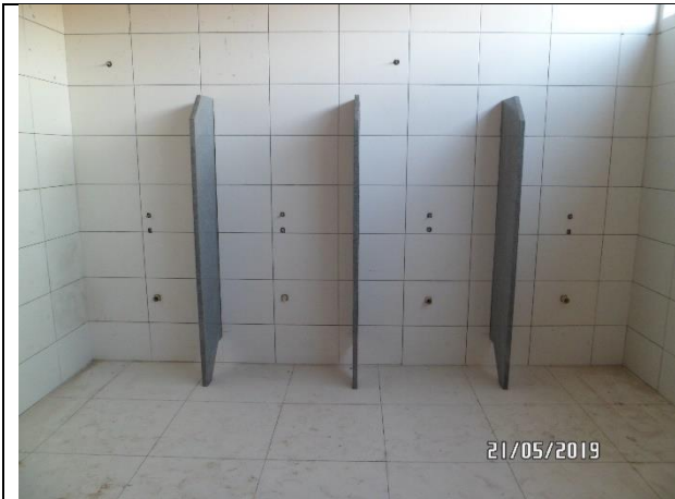
Foto 09 – Vista divisórias mictórios (1º pavto).
