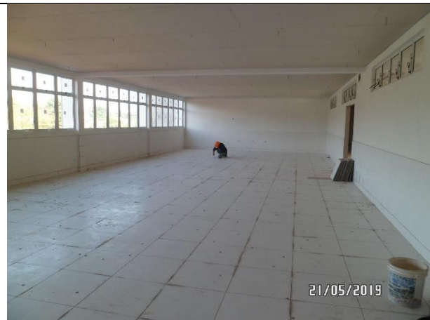
Foto 11 – Vista aplicação de rejunte.
