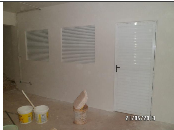
Foto 07 – Vista acesso área técnica subsolo.
