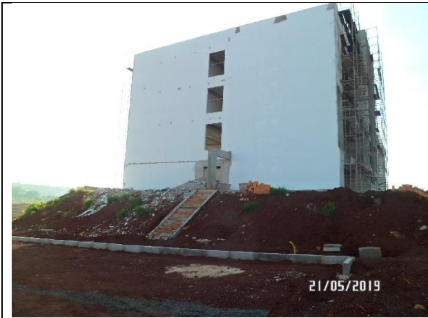
Foto 03 – Vista fachada acesso principal.
