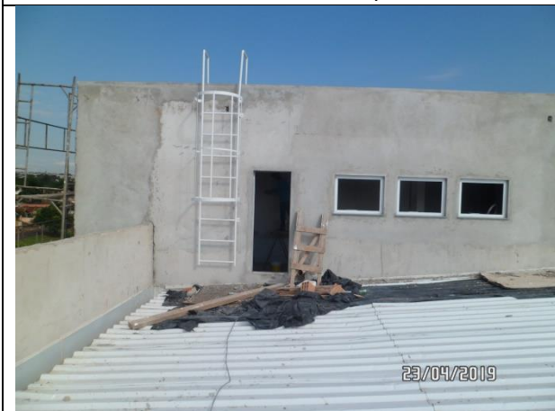
Foto 11 – Vista acesso laje área técnica.
