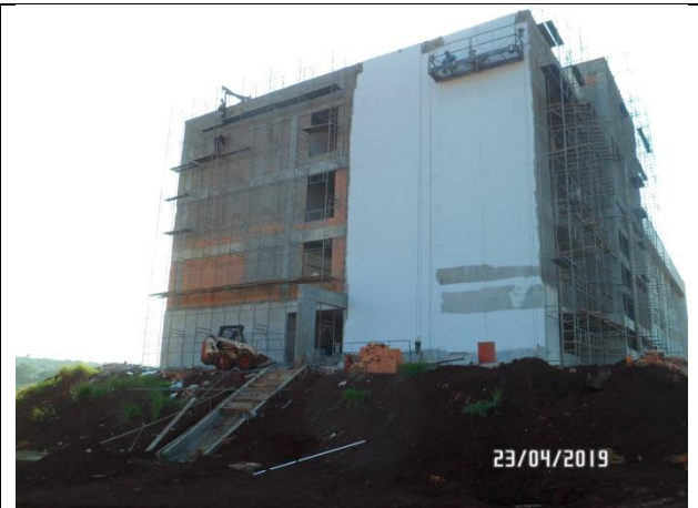
Foto 04 – Vista lateral da obra.
