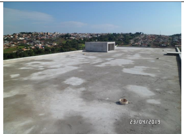
Foto 12 – Vista laje área técnica.
