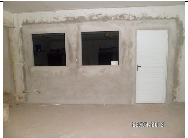
Foto 10 – Vista acesso cisterna subsolo.
