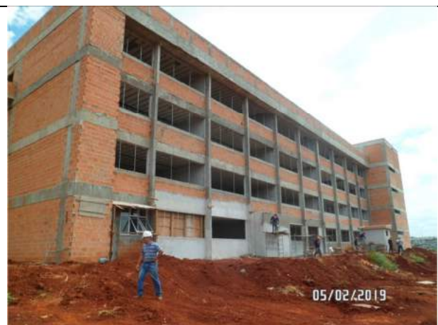
Foto 02 – Vista geral da obra
