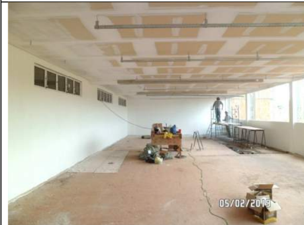
Foto 07 – Vista início pintura interna
