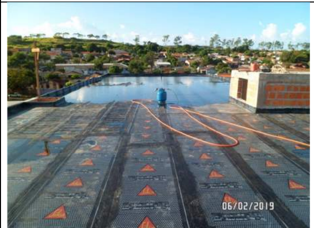
Foto 08 – Vista manta cx d'água (teste estanqueidade).
