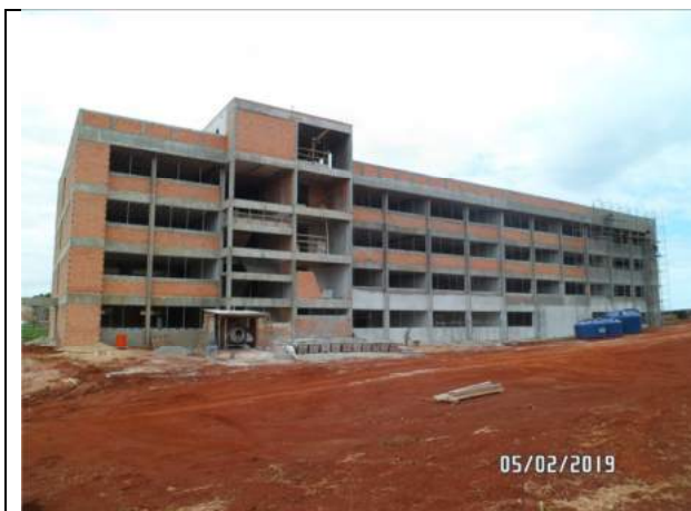
Foto 01 – Vista geral da obra
