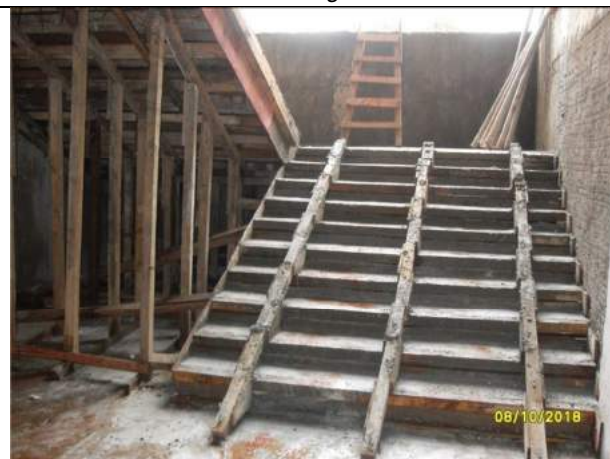
Foto 03 – Vista escadas subsolo
