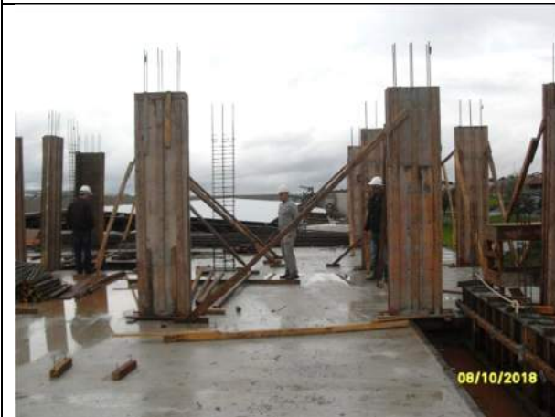
Foto 07 – Vista pilares barrilete
