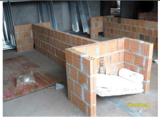
Foto 06 – Vista bancadas laboratórios
