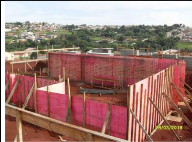
Foto 07 – Cortina de contenção – subsolo
