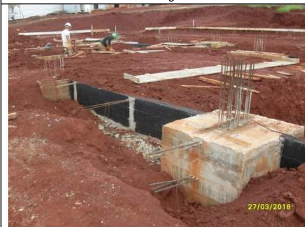
Viga baldrame impermeabilizada
