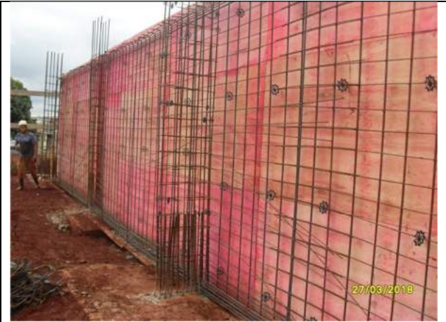
Foto 08 – Montagem armadura – cortina de contenção
