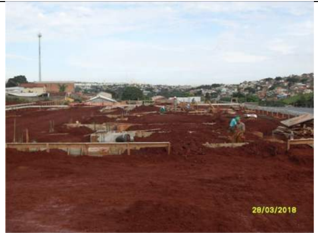
Foto 02 – Vista geral da fundação
