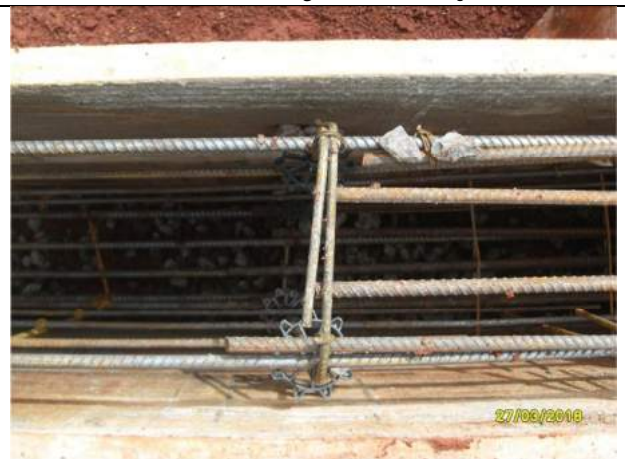
Foto 04 – Montagem de viga baldrame
