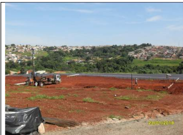
Foto 01 – Vista geral da obra
