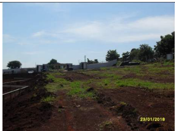
Foto 02 – Vista geral da obra
