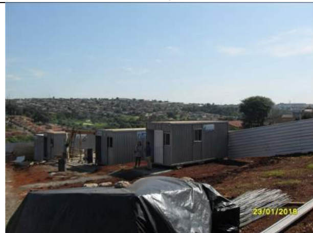
Foto 03 – Instalações de canteiro
