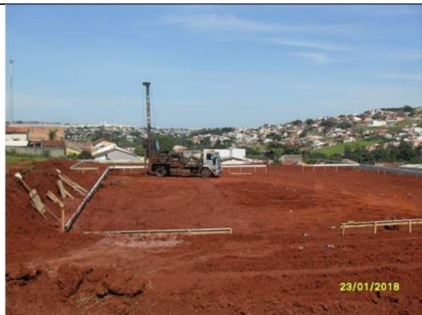
Foto 06 – Vista locação da obra
