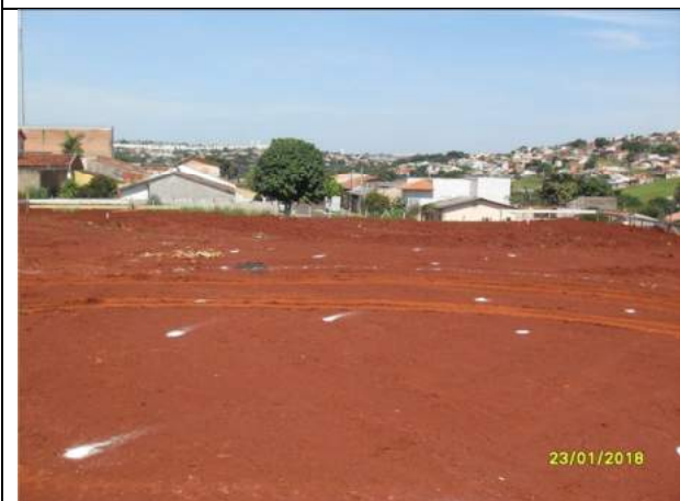
Foto 07 – Marcação das estacas (topógrafo)
