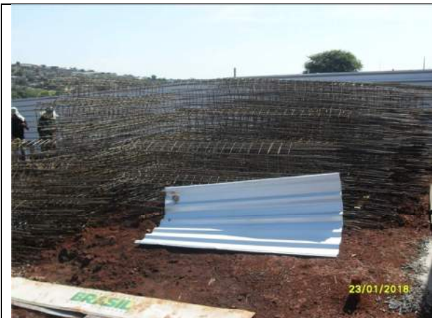
Foto 05 – Armaduras das estacas
